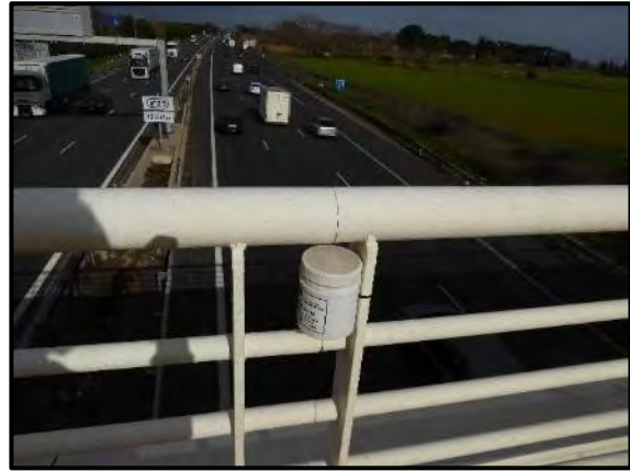
Autoroute A709 au niveau d'Odysseum TMJA 2016 = 119 942, source ASF Site Mtp_04_205
