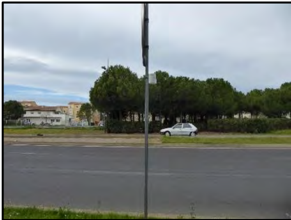
Avenue Mendès-France à Montpellier TMJA 2015 = 59 217, source ville de Montpellier Site Mtp_14_14
