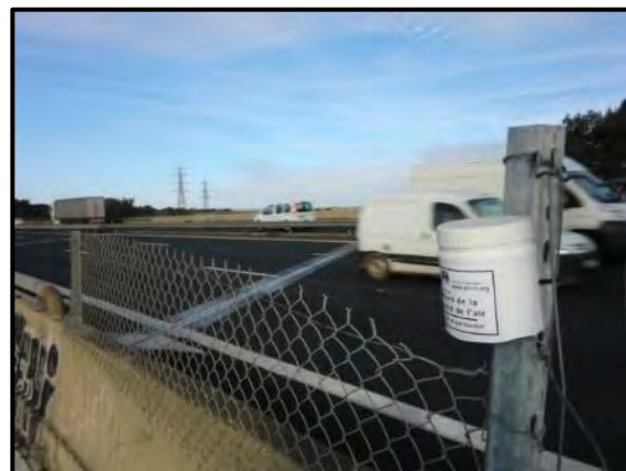
Autoroute A9 au niveau de Fabrègues TMJA 2016 = 70 205, source ASF Site Mtp_04_243
