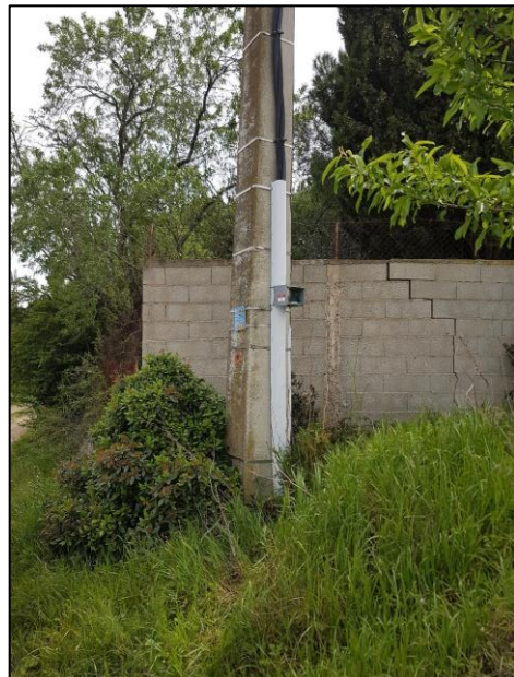
Site n°3 Rue des Ecureuils
