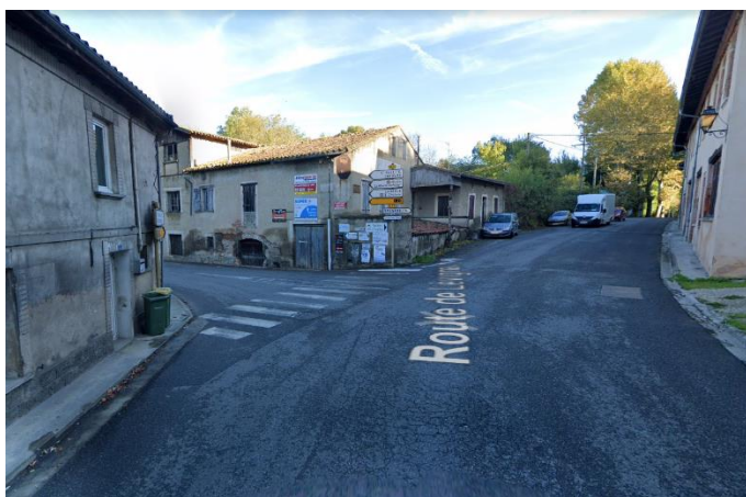
Vue de l'intersection entre la D1 et la route de Grenade (prolongement de la route de Lévigac)
