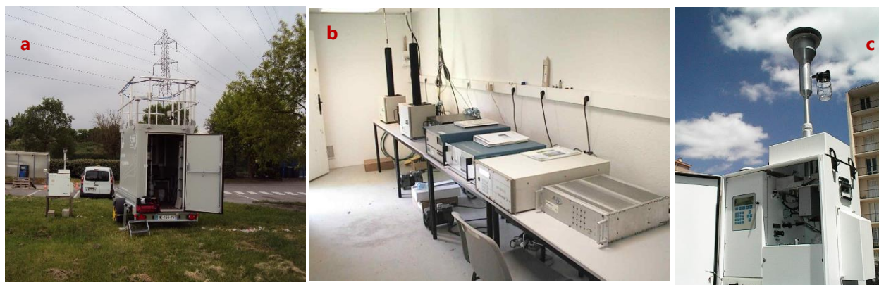
Remorque mobile renfermant les analyseurs installés sur le site de Laurencin (a), exemple d'analyseurs automatiques utilisés pour le NO 2 et PM 10 /PM 2,5 et pour la mesure des métaux (c).
