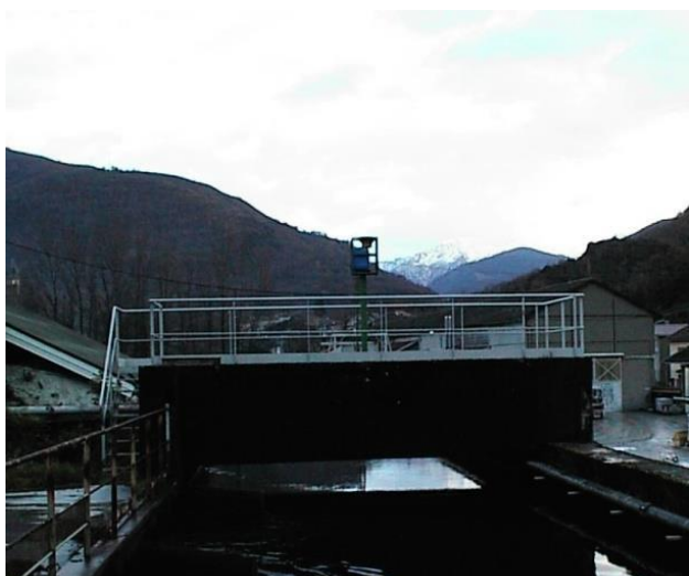
Site n°17 : Ancien Dégrilleur
