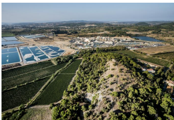
Figure 1 : Site d'ORANO-CE Malvési à Narbonne
